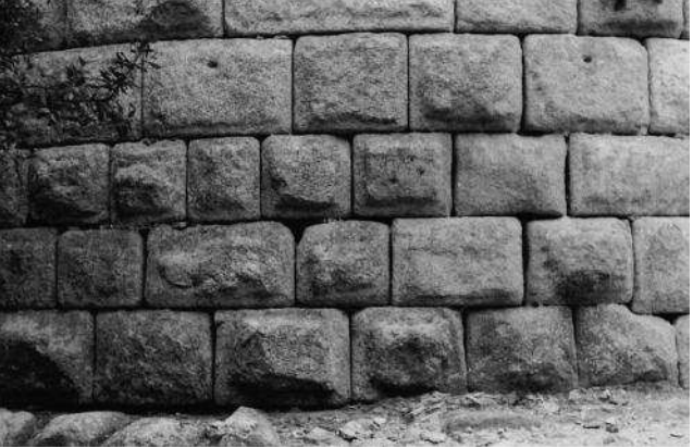
Torre de la Mora, a la Serra de la Guaita
