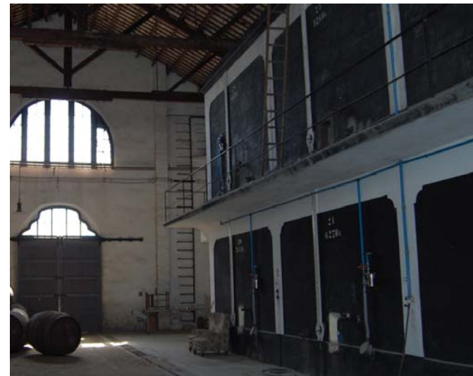
Tines de formigó del magatzem principal
