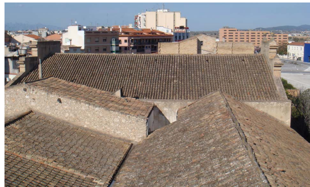
Cobertes dels diferents mòduls del complex
