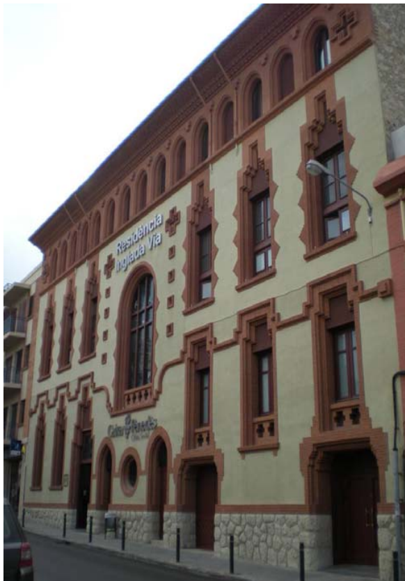
Façana exterior Asil Inglada Via
