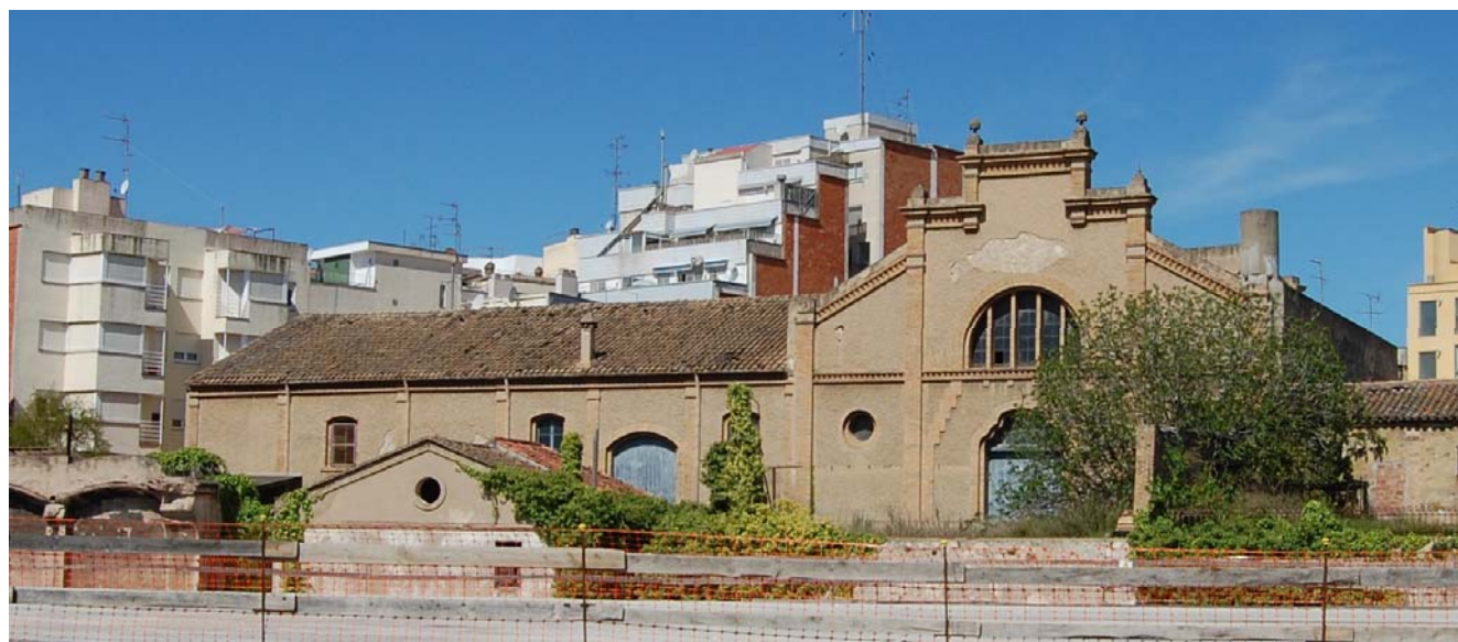
Façana sud-est. Vista des del carrer Comerç
