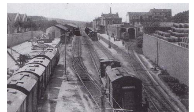
Vista general de la zona industrial a principis de segle XX
