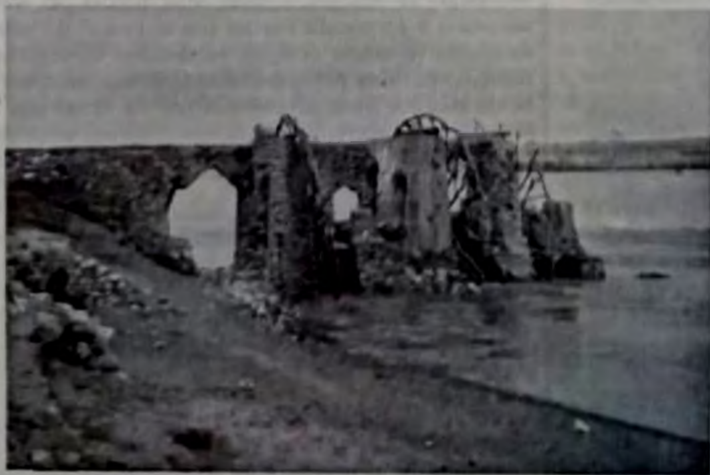
Noria (naúra) ó rueda elevatoria, á orillas del Eufrates (Hadha)
